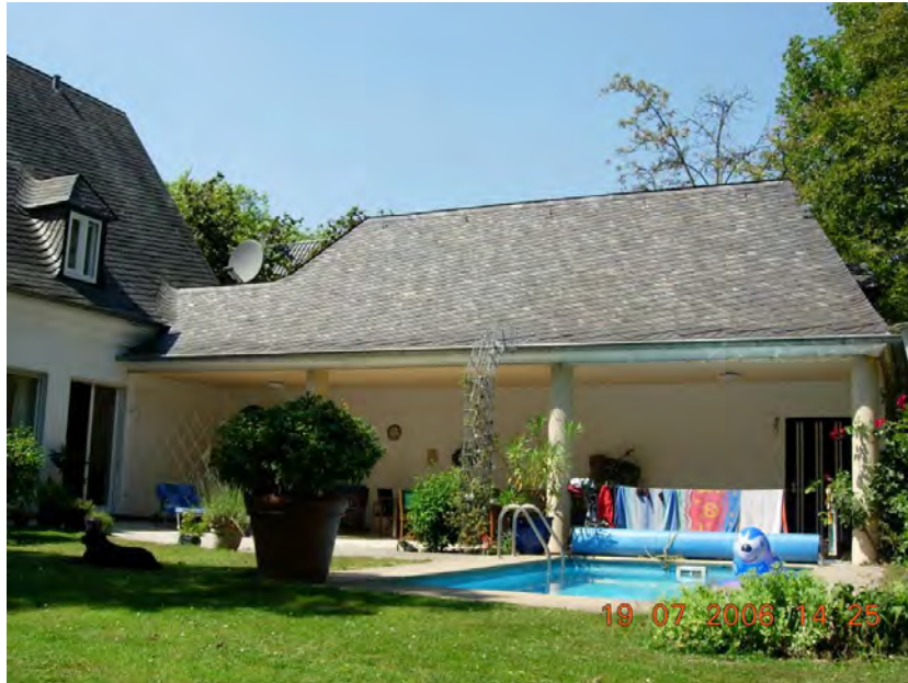
Doppelgarage mit angeschlepptem Freisitz (davor Ausschwimmbecken)
